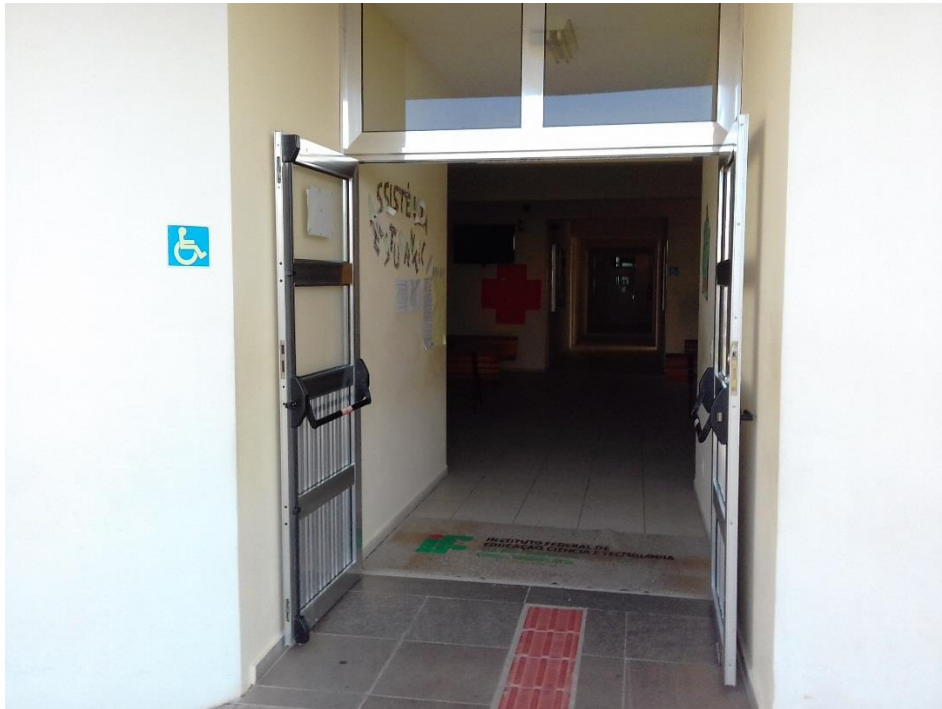
Figura 7 – Corredores e aberturas largas para facilitar o acesso aos ambientes.
