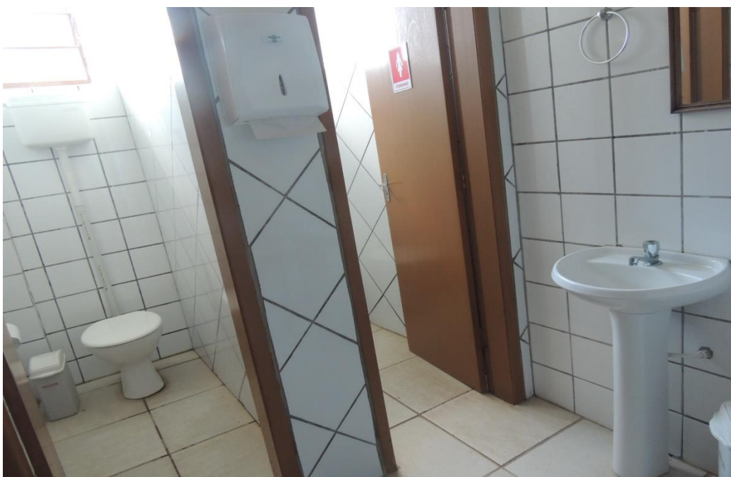
Banheiro feminino ( Bloco 1).
