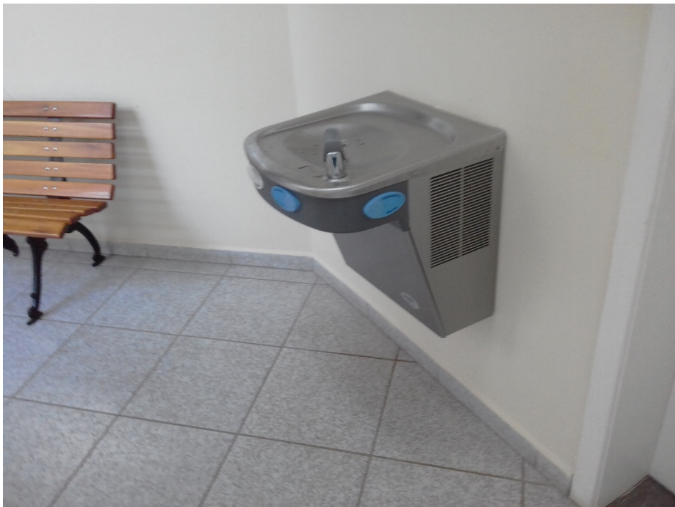
Figura 6 – Bebedouro com acessibilidade é projetado para atender pessoas com deficiência física e mobilidade reduzida.
